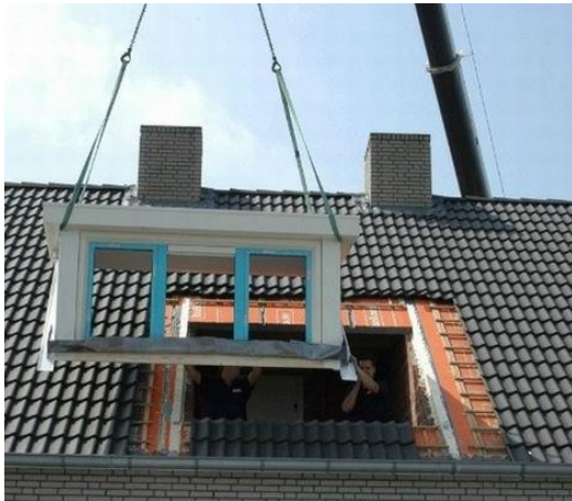
Afbeelding 6 Plaatsing van de prefab dakkapel
