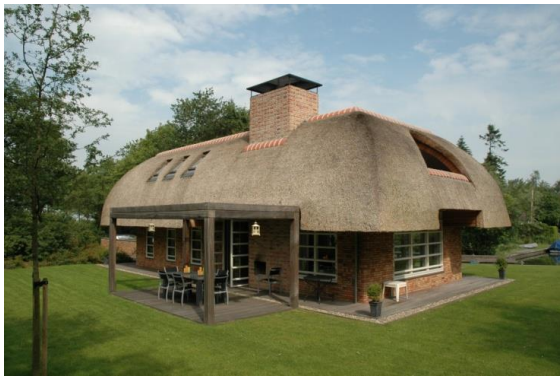
Afbeelding 16 Woning onder architectuur (Noordwestzes Architecten Alkmaar, foto: kramersbouwbedrijf.nl)
