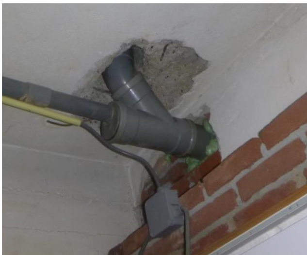
Figuur 1 PVC-doorvoering door vloer tussen winkel en woning Figuur 2 Dwarsdoorsnede met positie
